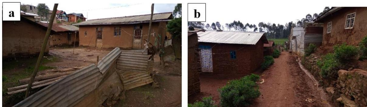
Fig. 1. Maisons construites en terre battue non entretenue utilisant des tôles usées comme clôture au quartier Lumumba sur l'Avenue Lubero (a) et dans la cellule Kaluvu (b)
