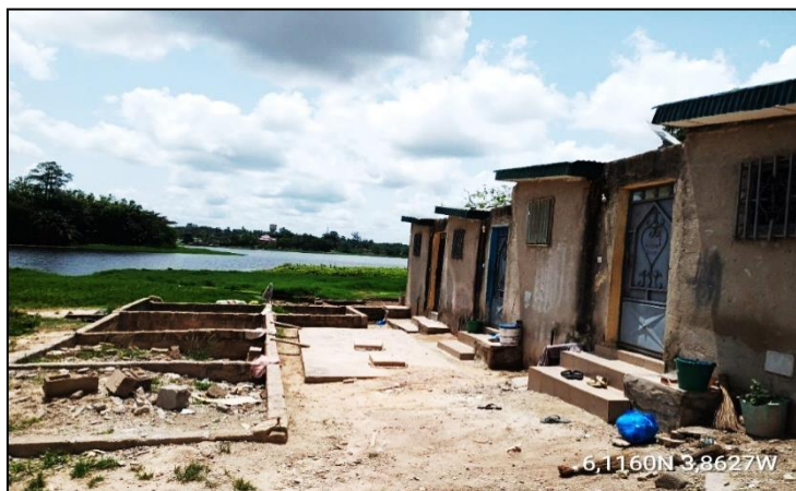
Photo 2: Des maisons construites à lisière de la rivière "Massan"
