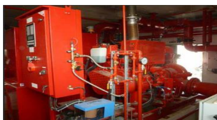
Fig. 2. Poste de contrôle sous-eau
