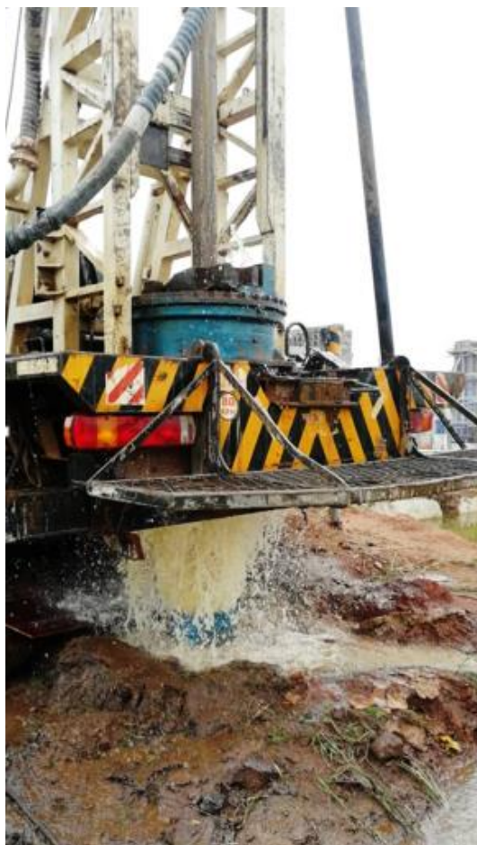
Fig. 2. Forage d'eau de Diovo (Forage destructif)
