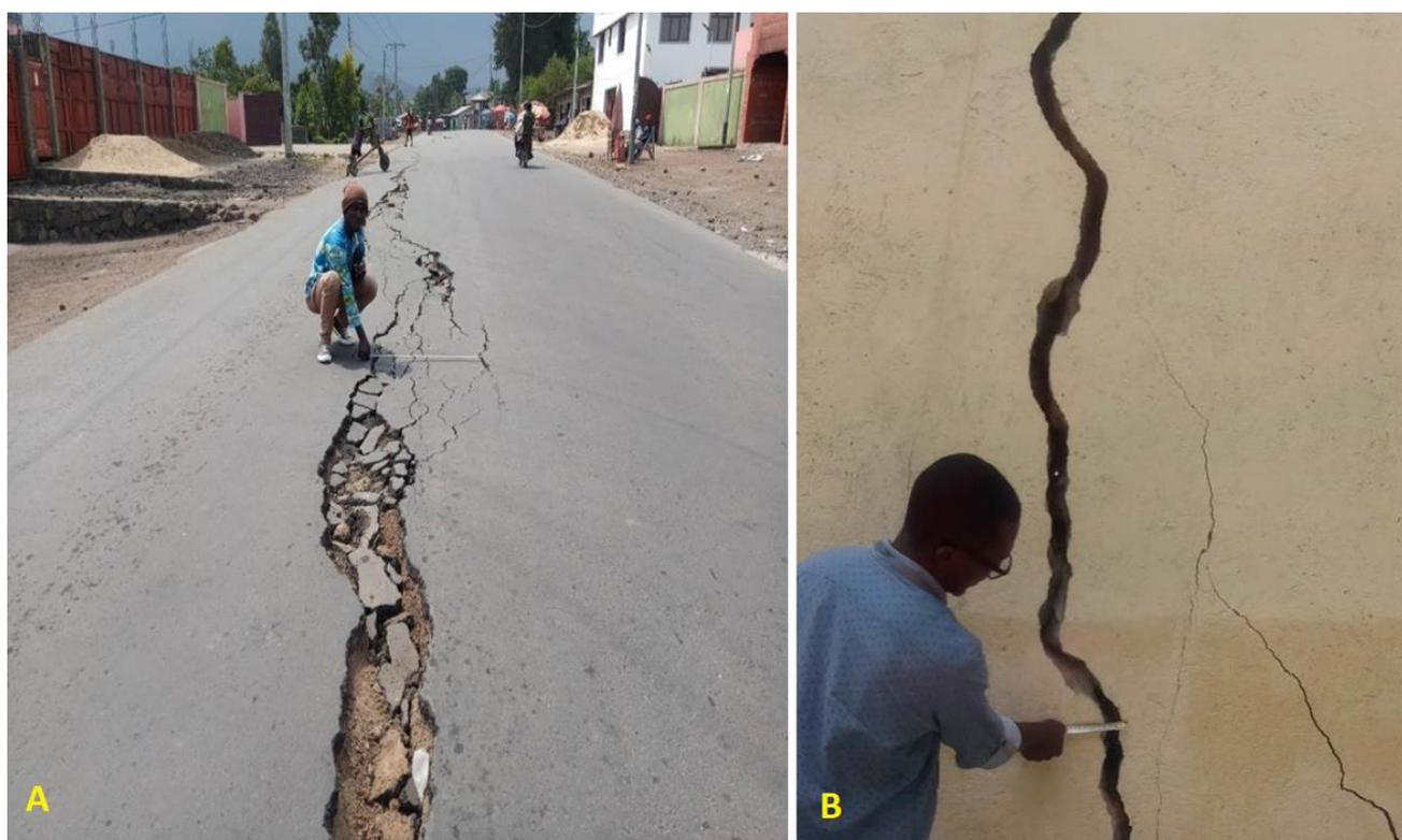
Fig. 9. (A) Fracturation de la route vers l'aéroport de Goma (B) Fissuration du mur d'une maison
