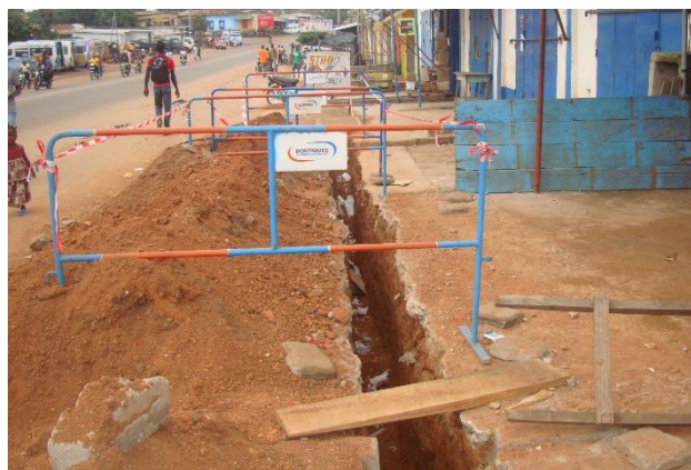
Photo 6: Creuset pour l'enfouissement de la fibre optique dans la ville de Bouaké
