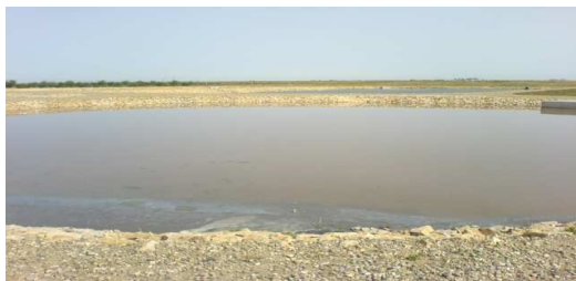
Fig. 1. Les bassins anaérobies de la STEP
