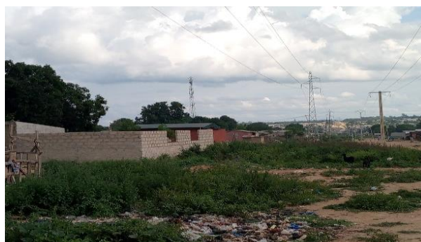
Fig. 6. Une nouvelle maison en construction dans le quartier d'abattoir après le déguerpissement
