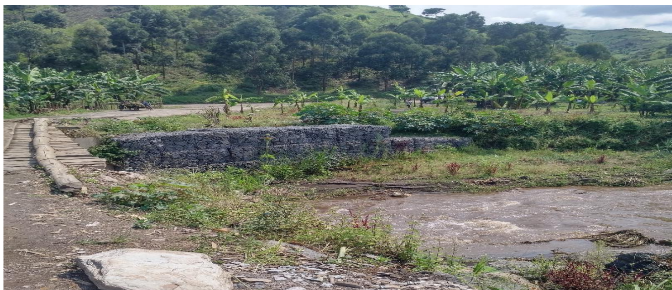
Fig. 3. Ouvrage en bois sur culée en gabions sur la rivière Kahira
