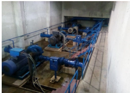
Fig. 3. Groupes motopompes de la partie refoulement
