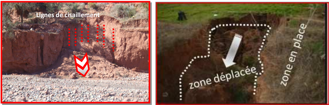
Photo 8 : Le phénomène de glissement en masse an niveau des berges de l'Oued Rdat
