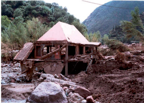
Photo 11 : Maison détruite par la crue du 17 Aout 1995 (source : [10]. saidi at al, 2010)
