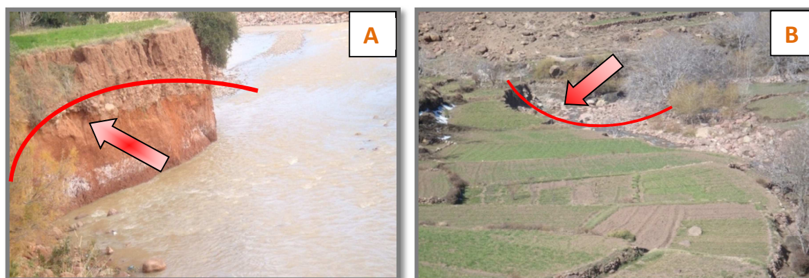
Photo 5 : Berge concave au niveau de l'Oued Rdat : A en aval à Sidi Rehal et B en amont à Iswal.
