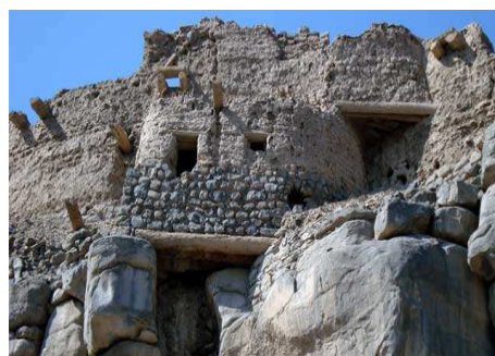
لوحة 9. معالجة عدم انتظام الكتل الصخرية
