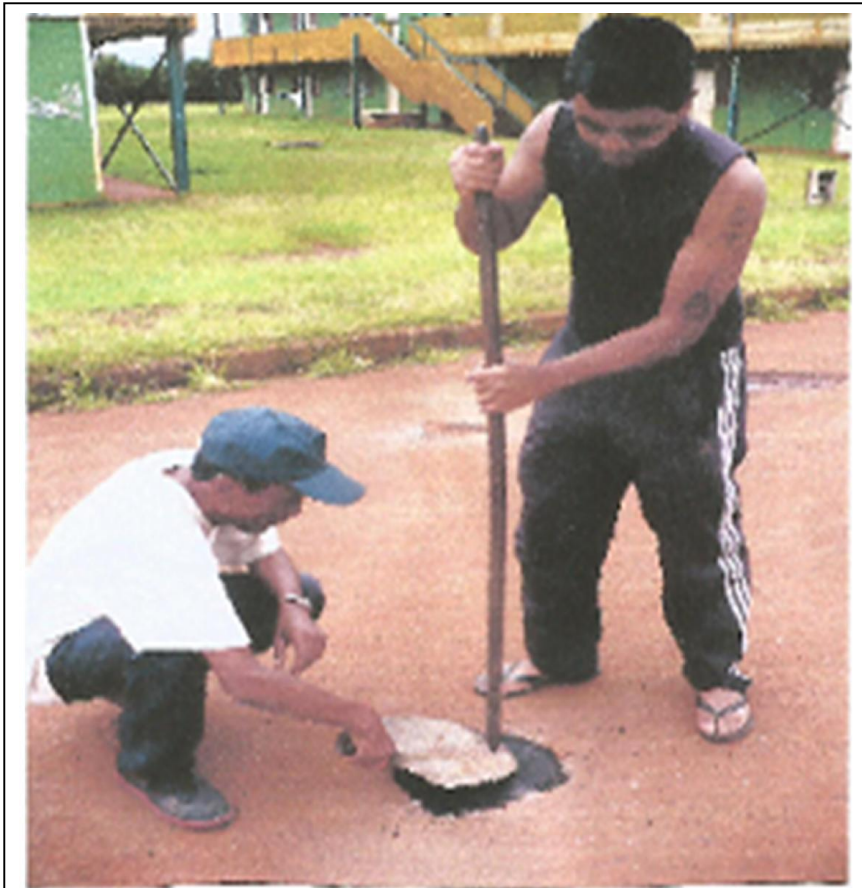
Figure 3b: Compactage sur le trou à colmater après cuisson
