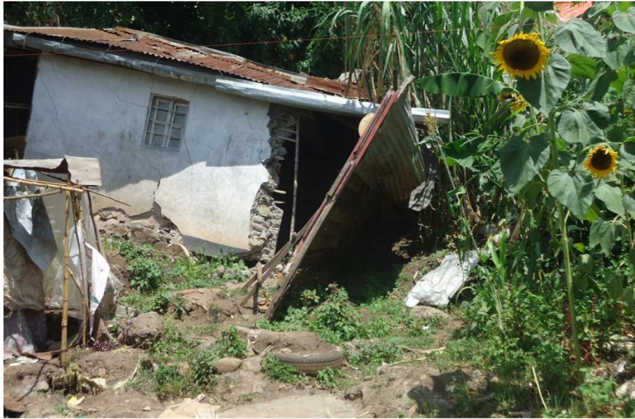
Photo 5 : Aperçu de l'affaissement de maison sur le site de Nyakavogo (Source : BIRINGANINE, mai 2014)
