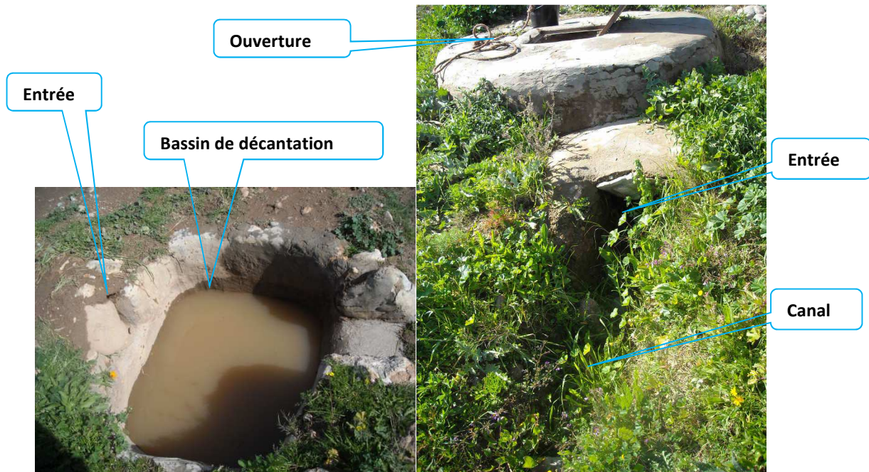
Fig.4 Détail d'une citerne (tanoutfi) et ses composantes.
