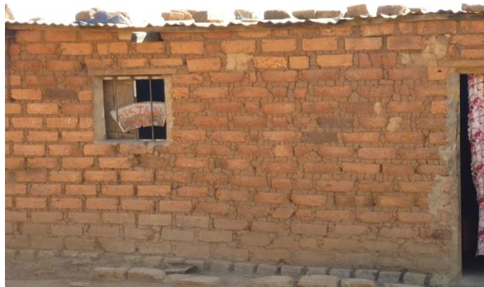
Fig. 2. Cette photo montre une maison en brique adobe sur la voie principale
