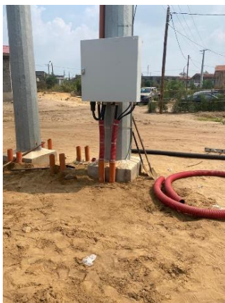
Fig. 15. Armoire de Commande montée sur Poteau
