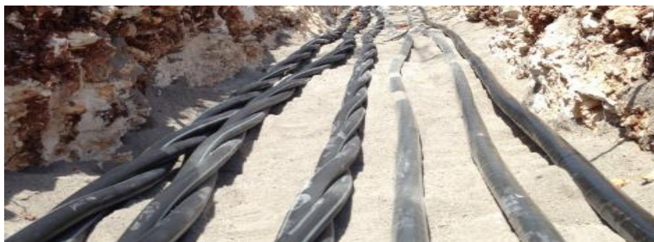
Fig. 2. Réseau de distribution souterrain
