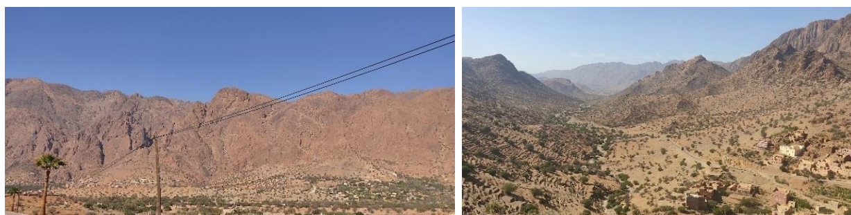
Fig. 3. Nouvelles constructions à proximité de la route (Territoire d'Ammelne) [18]
