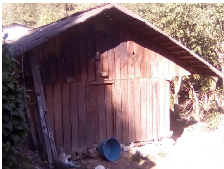
Fig. 1. Las casas de la región de Huachinango son de madera, pero lo más importante es que la estructura del techo es con parteaguas consta de dos alas
