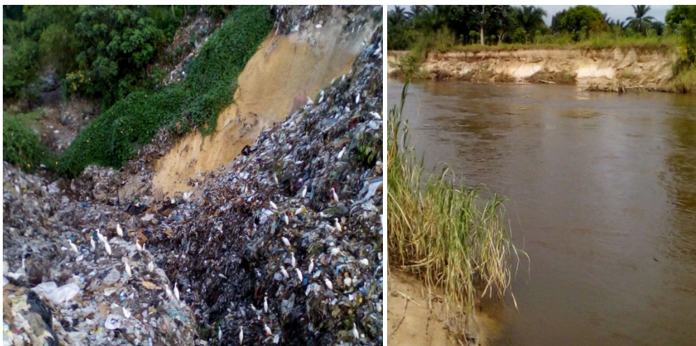
Photos 13 et 14 : ravin transformé en dépotoir et érosion des sols à l'intérieur de la rivière N'djili
