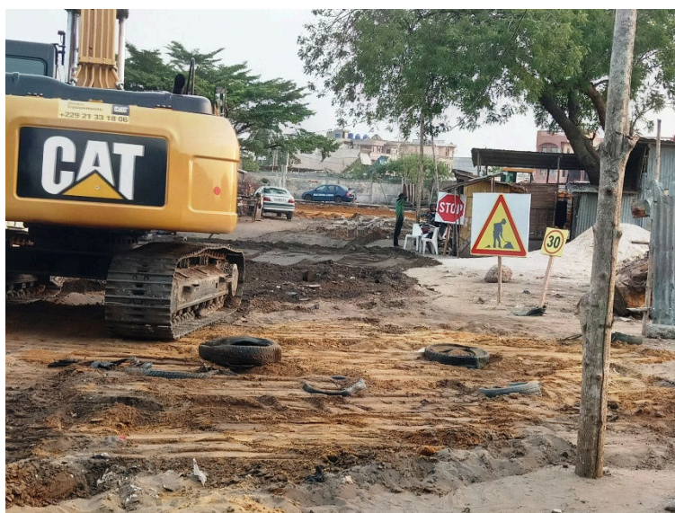
Photo N° 02 : Panneaux temporaires de chantier
