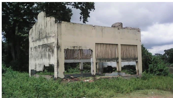
Photo 2 : La station de pompage du périmètre Yabra
