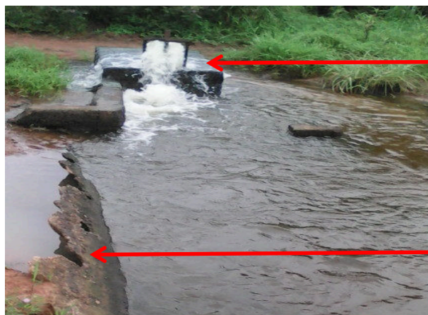
Photo 1 : Vanne et béton du canal d'irrigation dégradé à Yabra
