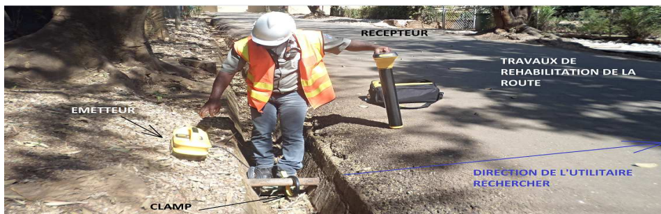
Photo 11: Prospection en mode Actif direct : La Pince à champ Magnétique (Clamp) Base camp / Fungurume, April 2014
