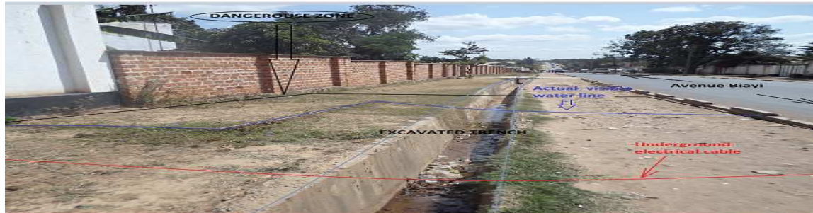
Photo 14 : travaux d'excavation pour les drainages de la voirie sur Biayi/ Lubumbashi RD.Congo 2012
