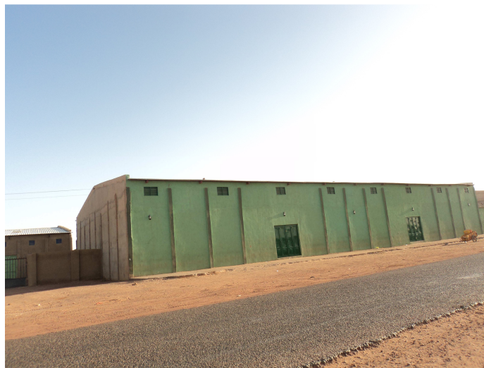
Photo n°2 : un entrepôt en matériaux définitifs à Mai Mougia
