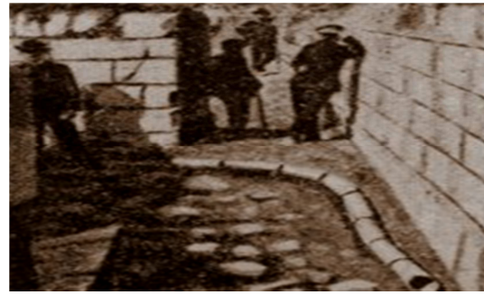
لوحة 11. أنابيب المياه المغيبة بحائط الحمام
