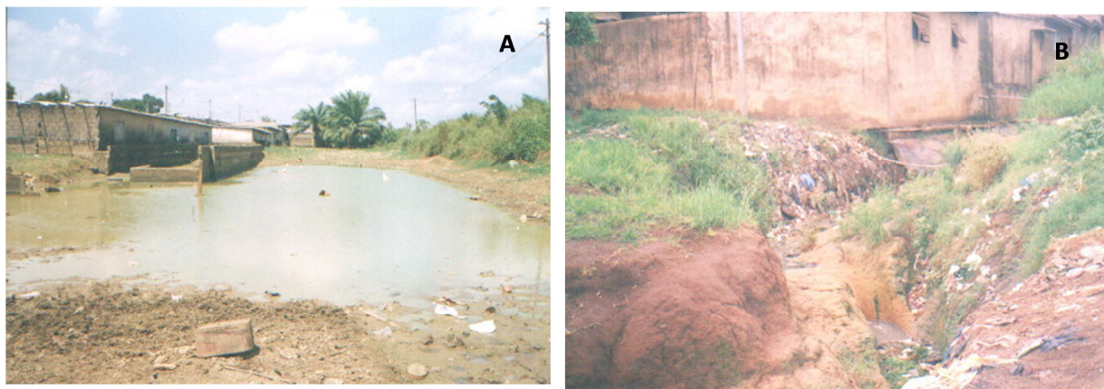
Fig. 5. Impact des eaux pluviales non drainées sur les quartiers précaires. A : Abandon d'une concession suite à l'inondation et création d'une marre à Anonkoua; B : Effet de l'érosion sur la fondation d'une maison à Sagbé.
