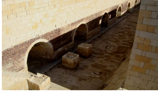
لوحة 21. القلعة بعد الترميم من الداخل
