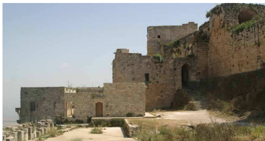
لوحة 20. المنطقة الشرقية للحصن الداخلي والمدخل
