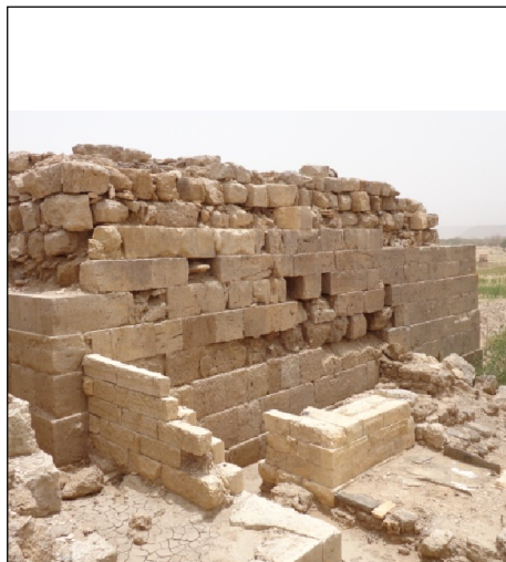
الشكل 11: تقنية البناء في المبنى الشمالي (الباحث)
