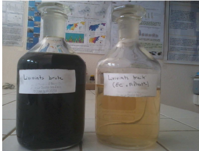
Fig. 2. Aspect visuel des Lixiviats bruts et traités par électrocoagulation-filtration
